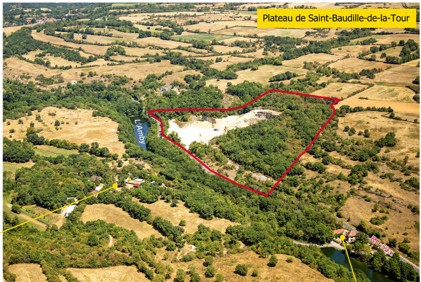
Vue depuis le sud-ouest
